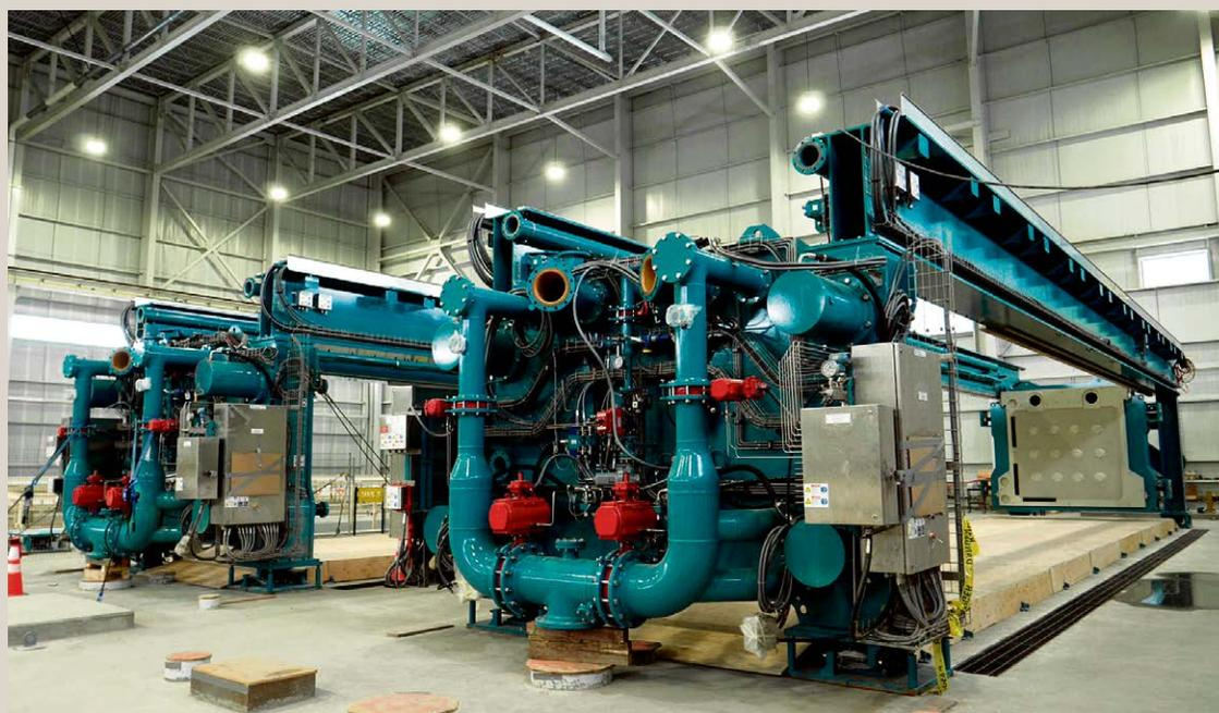
Deux des quatre filtres presses en cours d'assemblage dans l'Usine de filtration.
