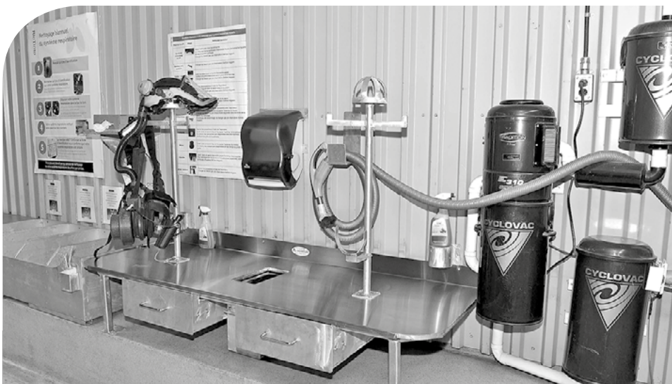
SUR LA PHOTO : La station de nettoyage a été ajoutée dans le bâtiment principal.
