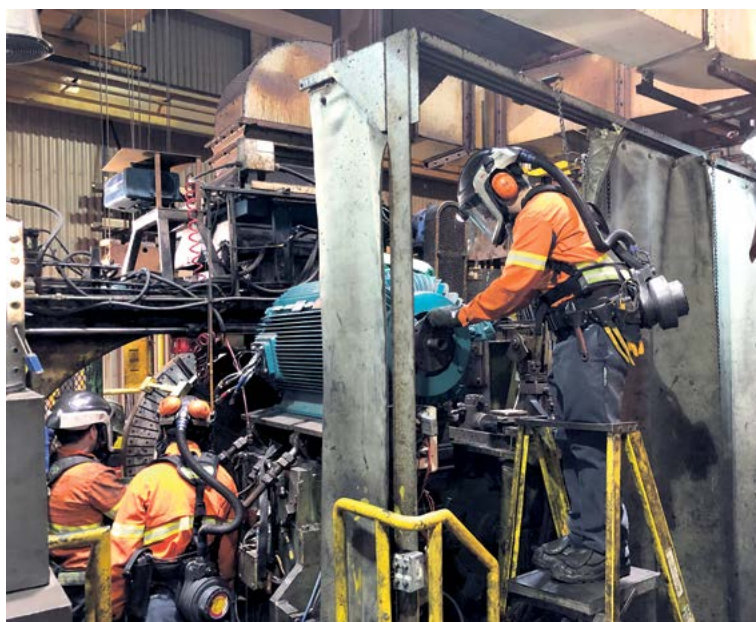
Changement du moteur du bobineur A.
