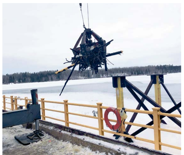
Au total, ce sont près de 50 voyages de camions qui ont dû être effectués pour évacuer le bois hors du site et redonner à la centrale sa pleine capacité de production.
