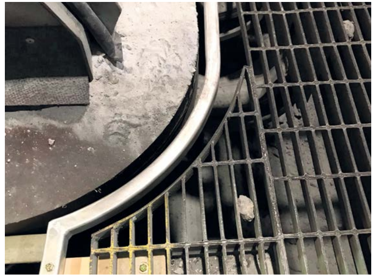
Les nouveaux guides fixes empêchent la grille de se déplacer et réduisent l'espace où il était possible d'y insérer le pied.
