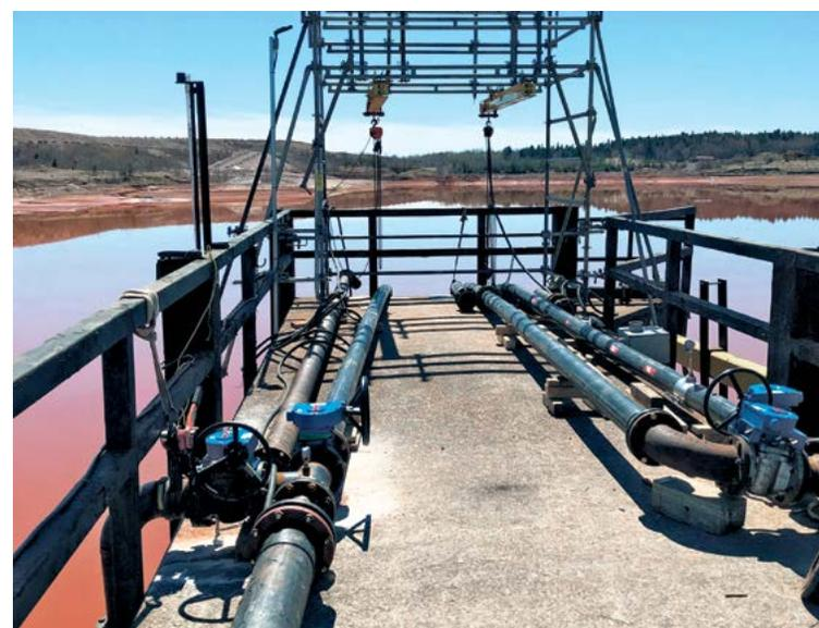
Système de conduites du bassin 4 au site de disposition des résidus de bauxite.
