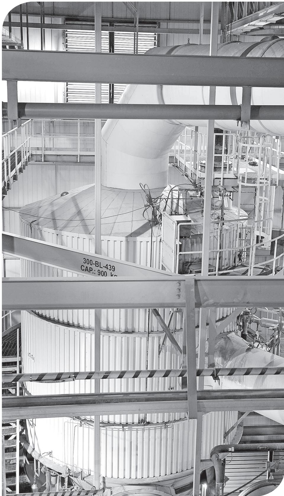
Les chevrons des épurateurs servent à recueillir le liquide évaporé. Avec le temps, ils s'encrassent et leur ancien design ne permettait pas de les nettoyer efficacement. Étant obstrués, il fallait donc fournir plus de vapeur afin d'augmenter la pression et lui permettre de s'échapper.
