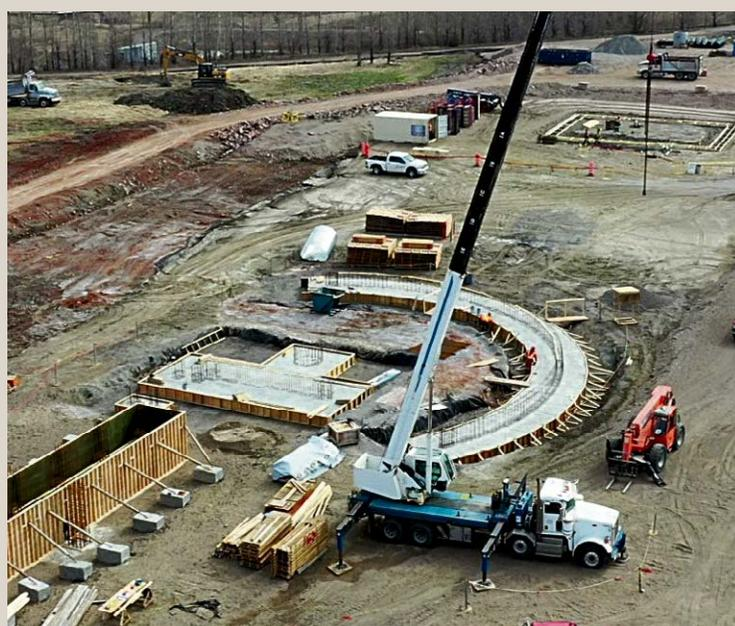
Les travaux en cours au Site de disposition des résidus de bauxite (SDRB) permettent déjà de visualiser l'aménagement de l'aire d'entreposage et de chargement des camions. Cette zone pourra accueillir jusqu'à 12 heures de production de résidus filtrés. Après avoir quitté l'usine de filtration et franchi les 800 mètres du convoyeur tubulaire, les résidus seront disposés dans la zone à l'aide de l'empileur pour ensuite être transportés par camion aux endroits prévus.
