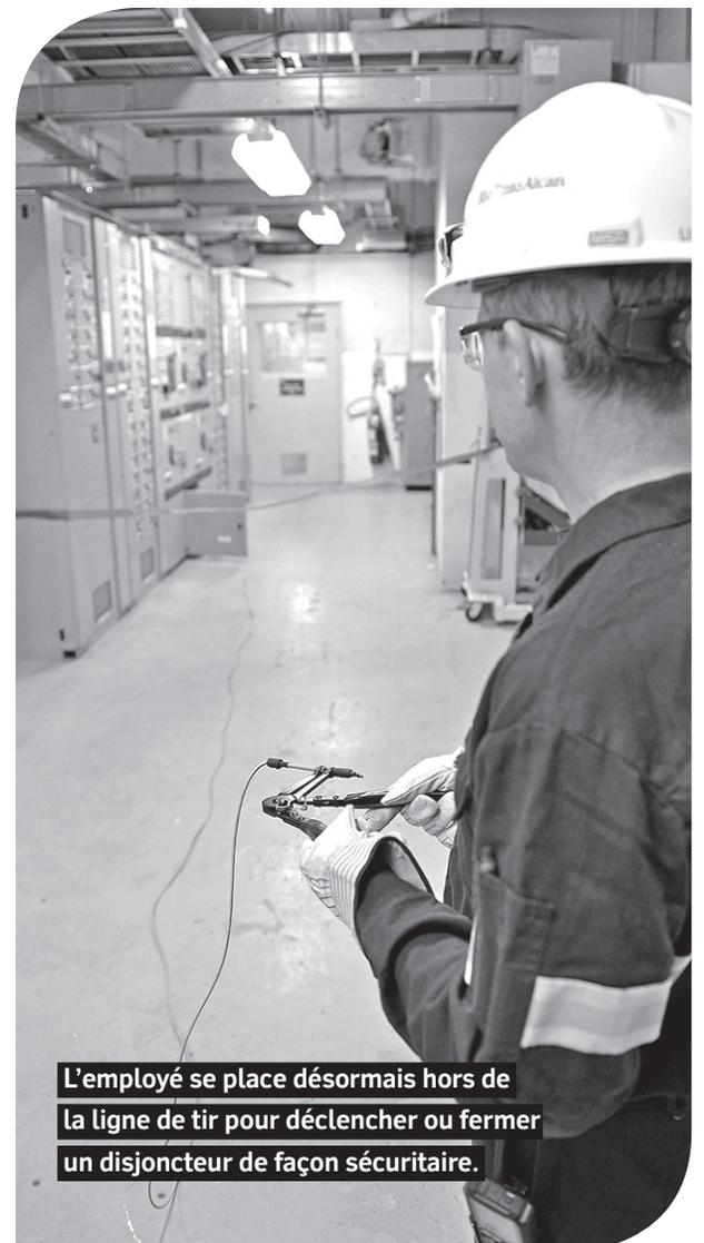
L'employé se place désormais hors de la ligne de tir pour déclencher ou fermer un disjoncteur de façon sécuritaire.
