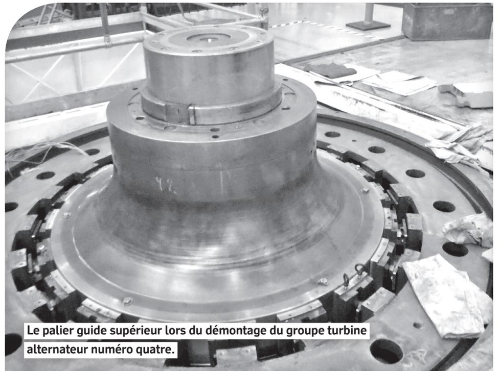
Le palier guide supérieur lors du démontage du groupe turbine alternateur numéro quatre.
